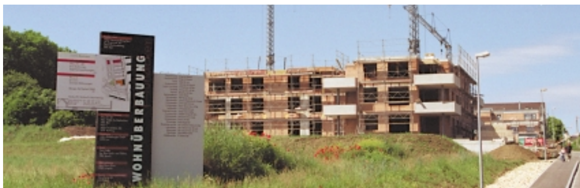
Baustelle in 2563 Ipsach
