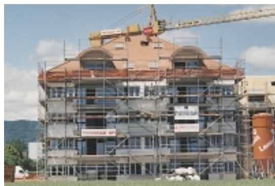
Baustelle in 1196 Gland
