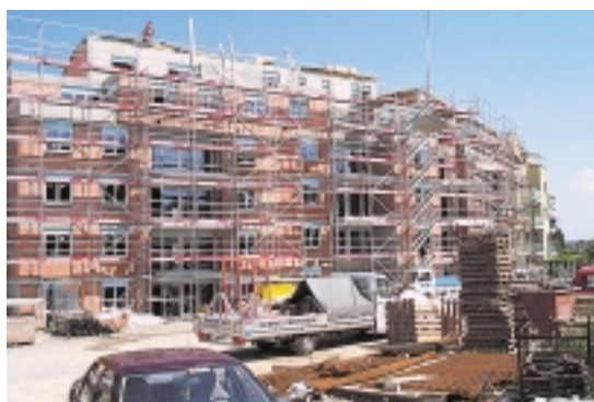
Baustelle in 5612 Villmergen
